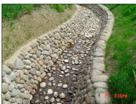
石積水路の設置
