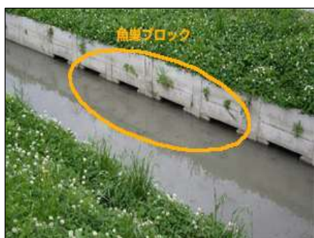
魚巢ブロックの設置
