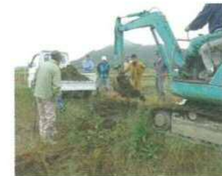
バックホーを使用 しての作業状況
